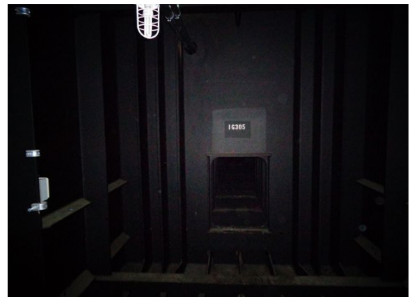
주형 내부전경 (지점부 교각)
